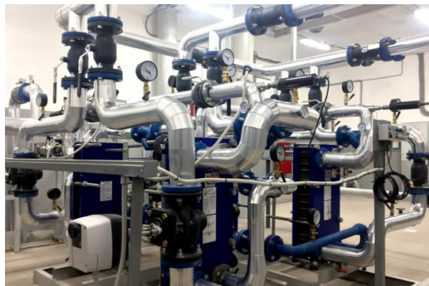
ЖКХ: ИТП, ЦТП
