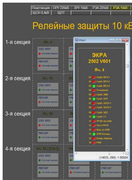
Рисунок 20. Список сигналов с терминала ЭКРА, установленного в ячейке 4 ЗРУ 10 кВ
